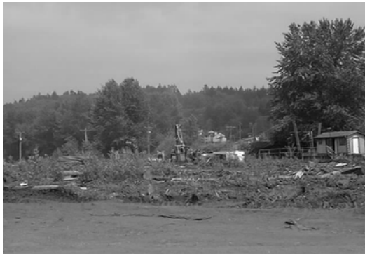
Real Brownfield: Renton, WA
